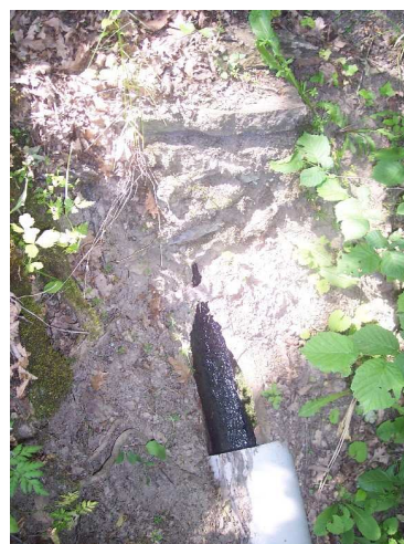
Canalisation rongée en amont du rejet
